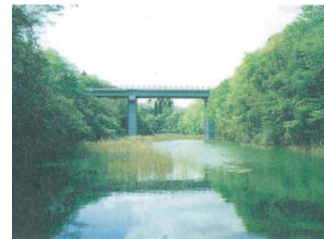
道路堤体部を橋梁に変更した谷津保全ゾーン
