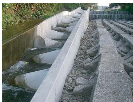
霞川に適した魚道形式(ハーフコーン型)
