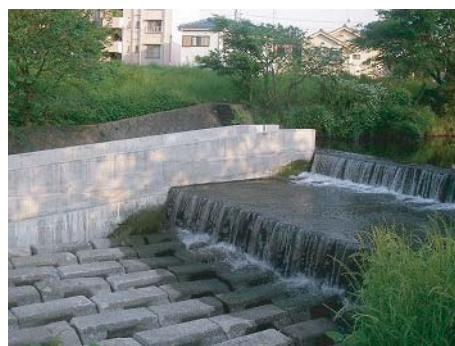
霞川の落差工
