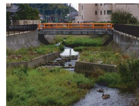
魚類の遡上に配慮した緩勾配にした落差工
