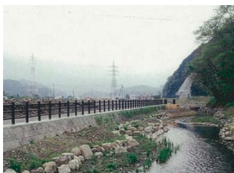
多自然型整備(巨石張り工)
