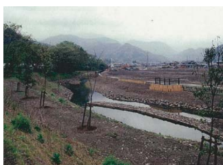
多自然型整備(木工沈床工)
