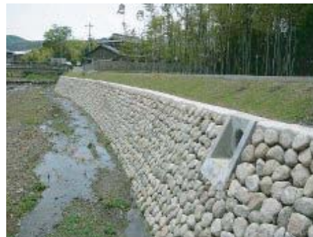
多孔質な護岸(アンカー式空石積み護岸)
