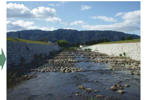
直壁型落差工から緩傾斜落差工への河川改修
