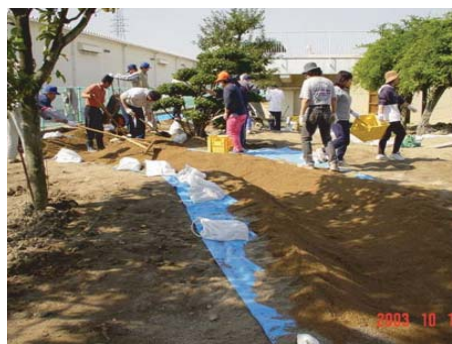
水路の防護シート土かけの様子
