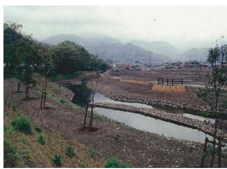
多自然型整備（木工沈床工）
