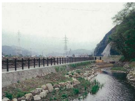
多自然型整備（巨石張り工）
