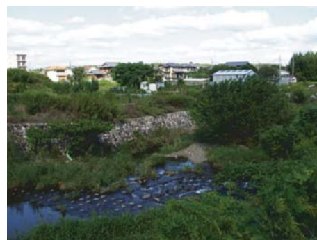
河道の堆積土砂の漂浚の様子
