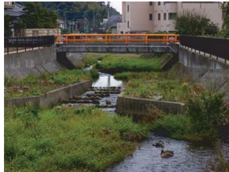
魚類の遡上に配慮した緩勾配にした落差工
