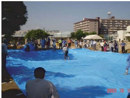
防護シート張りの様子
