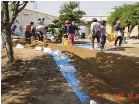
水路の防護シート土かけの様子
