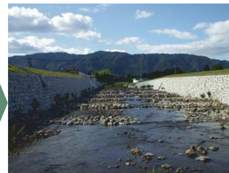
直壁型落差工から緩傾斜落差工への河川改修
