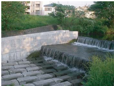
霞川の落差工
