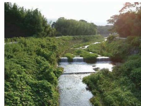
直壁型落差工から緩傾斜落差工への河川改修
