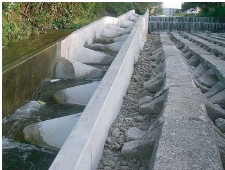
霞川に適した魚道形式(ハーフコーン型)
